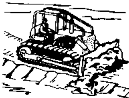
Fig. 4.48. Widening a Fill
