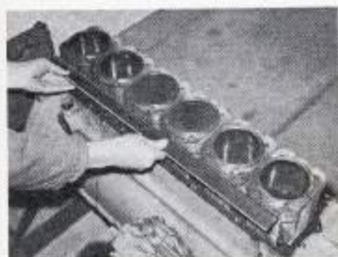
Alignement des cylindres à l'aide d'une règle.
